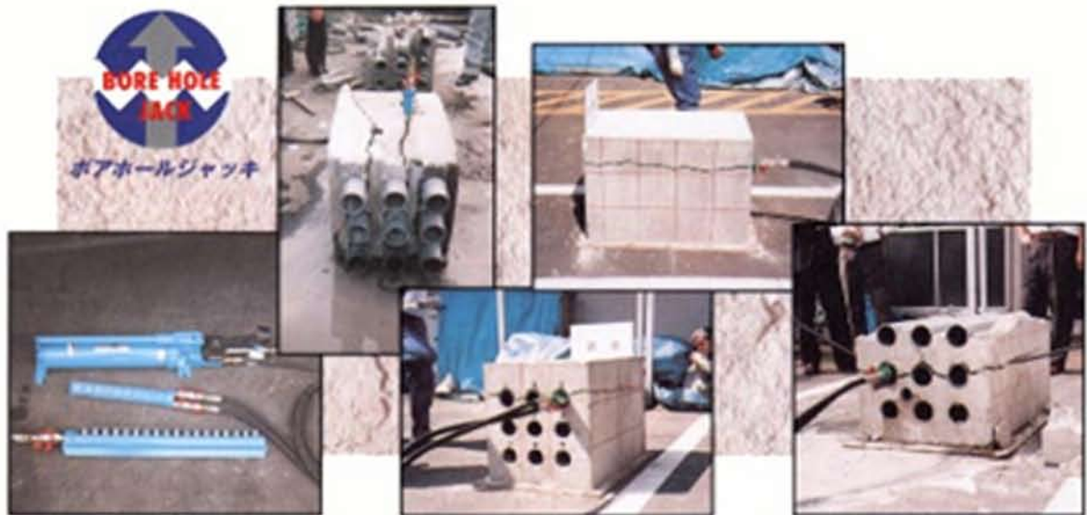
●例:NTTマンホール用防護コンクリートの破碎
